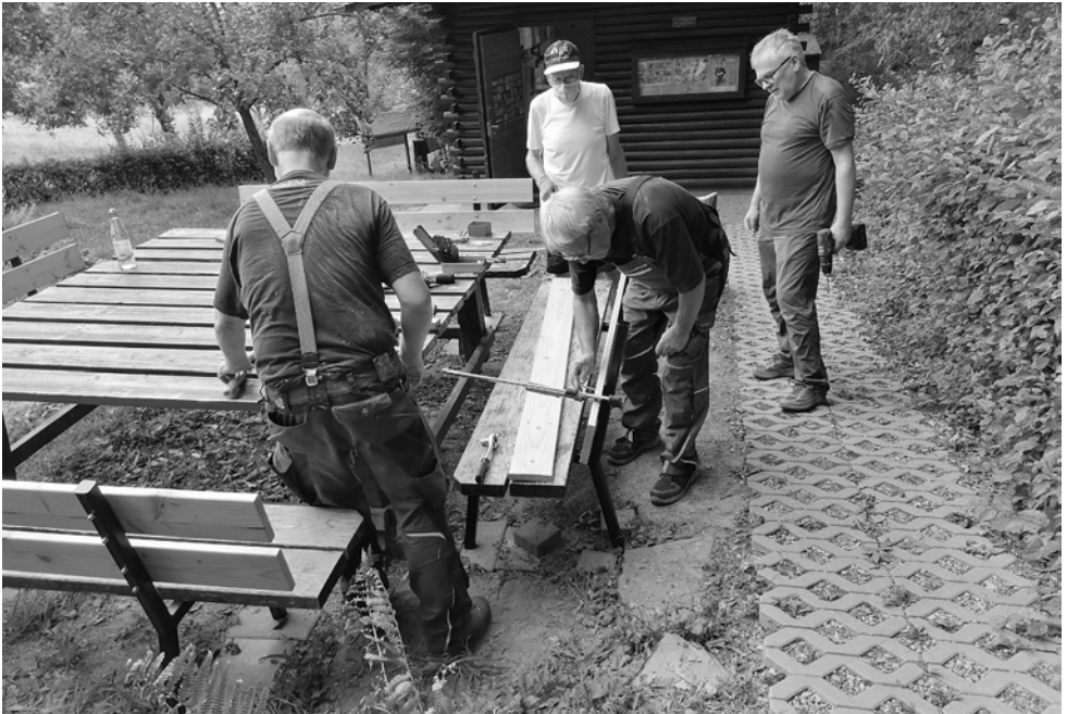
Die Hüttenbänke wurden erneuert | Foto: Susanne Bormann
